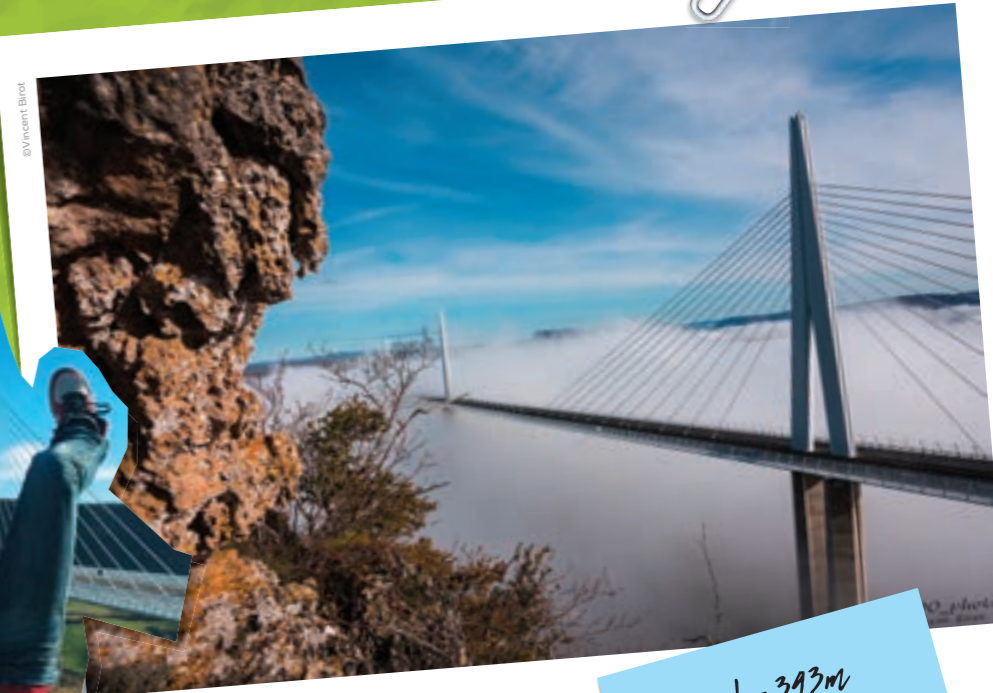
Viaduc de Millau
