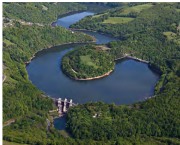
Barrage de Castelnau-Lassouts
