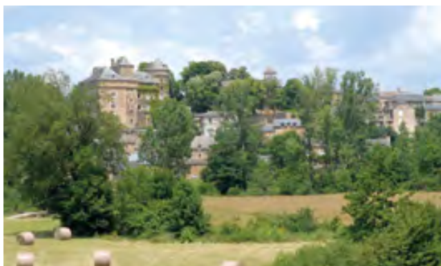
Montrozier : un village de caractère dominé par son château.
